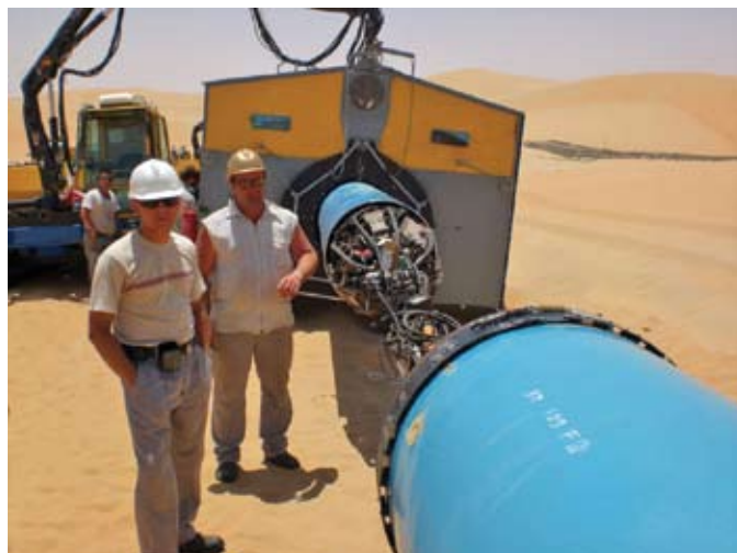
Внутренний центратор комплекса CRC AW, совмещенный со сварочной машиной
