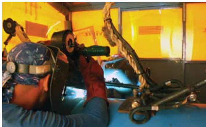
Сварка наружных слоев шва комплексом CRC AW Welding the outer layers on a CRC AW welder
