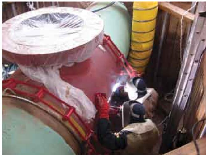
Монтаж и сварка разрезных тройников при «горячих врезках»
