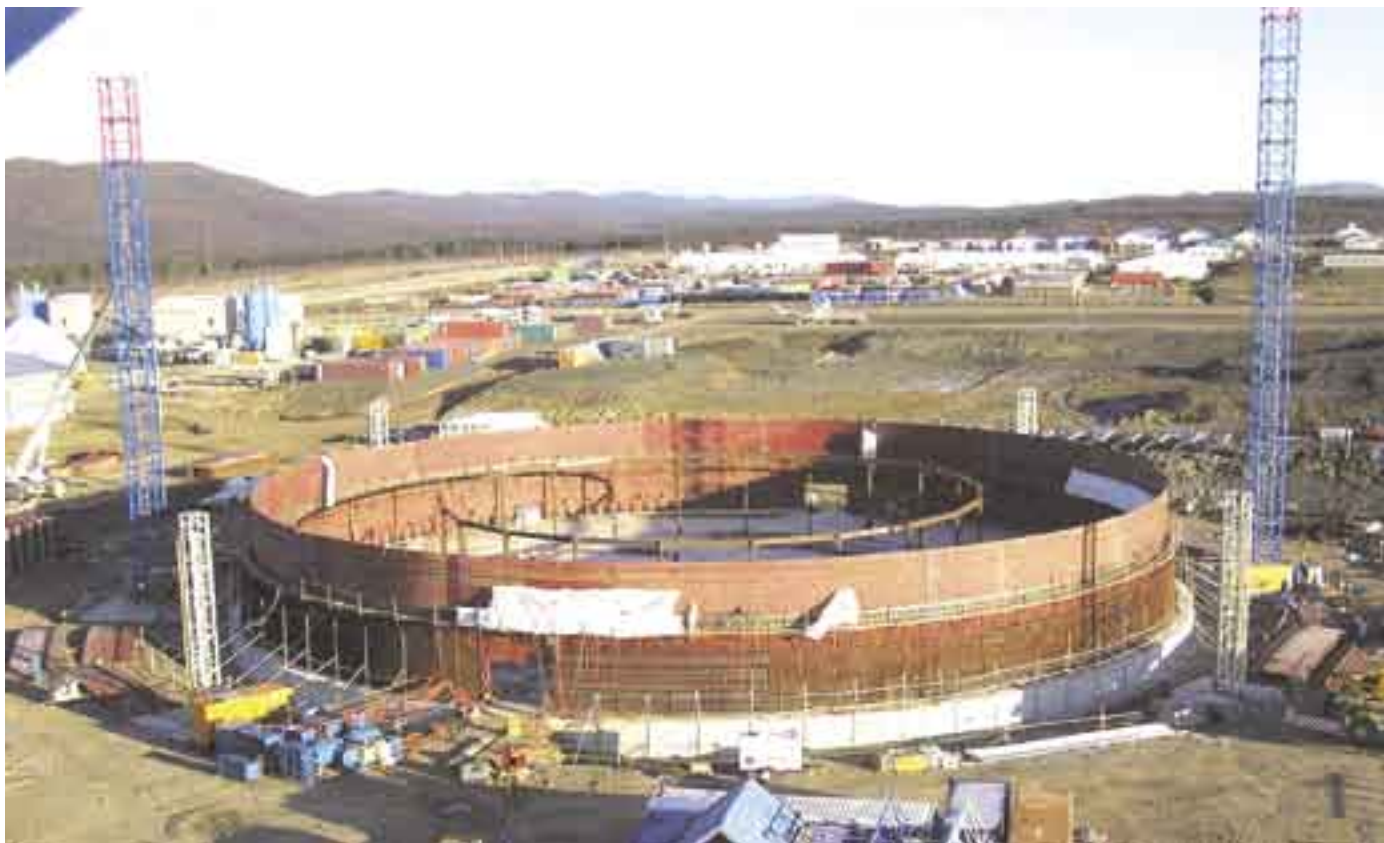
Рис. 3: Бетонирование фундаментной плиты резервуара СПГ на о-ве Сахалин Figure 3: Pouring the slab for an LNG tank on Sakhalin
