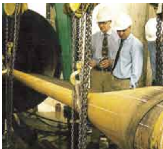
Рис. 11 – Разрушенный образец в процессе извлечения Figure 11 – Collapsed Specimen Being Removed
