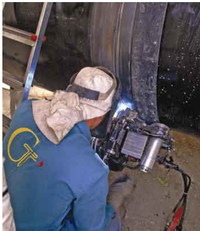
Рис. 1: Установка «Север» для электроконтактной сварки на строительстве газопровода Заполярное – Уренгой
