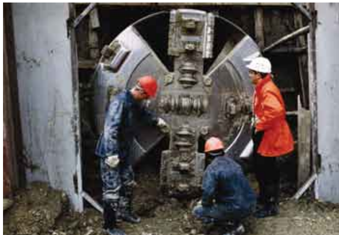
Рис. 3: Рабочий орган тоннелепроходческого комплекса, примененного на сооружении тоннелей под хребтами Кобыла и Безымянный
