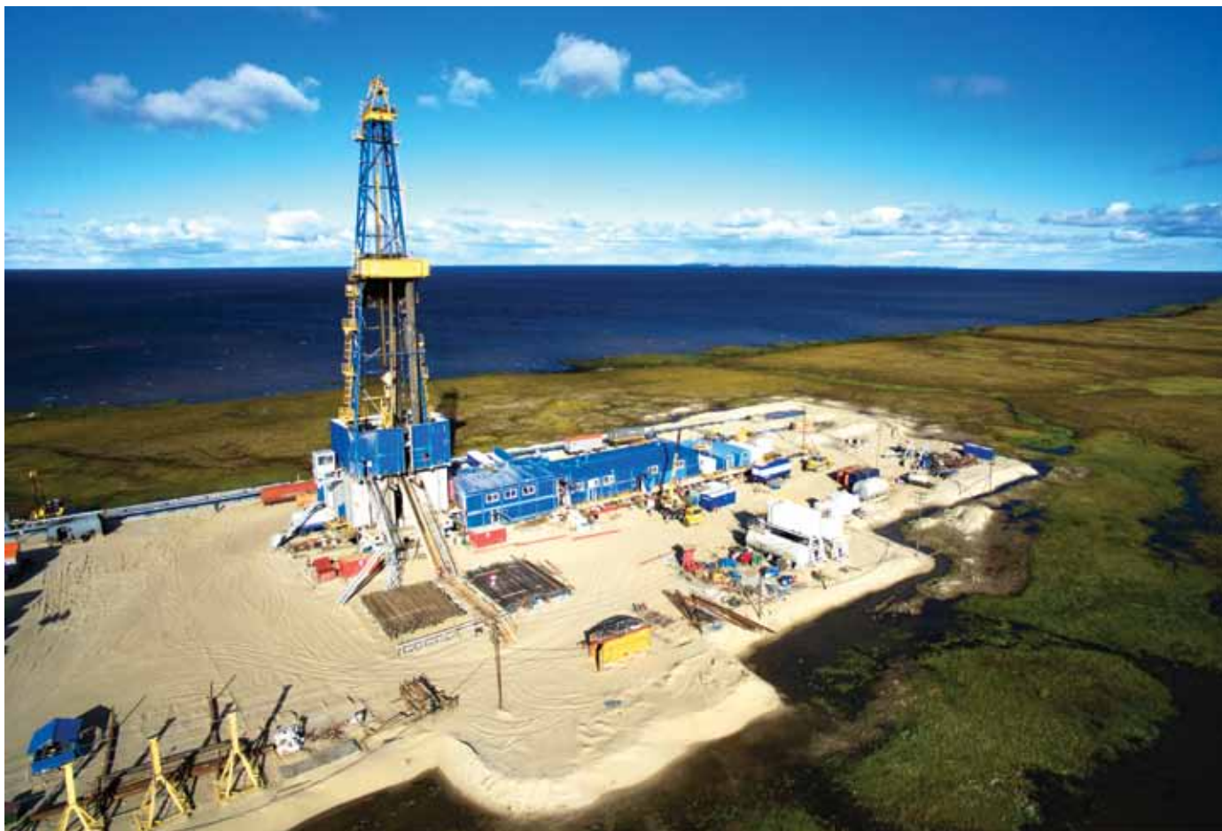
Рисунок 5. Буровая установка БУ-6500/450-ЭЧРК-БМ
