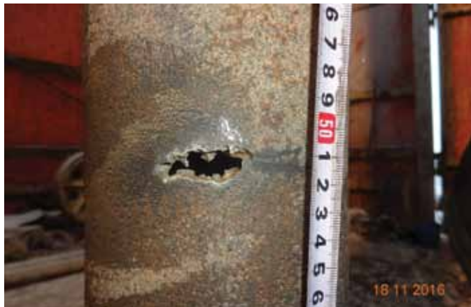
Рис. 4. Промыв тела бурильной трубы
