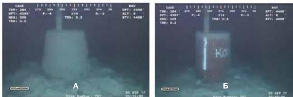
Рис.2: Устье скважины при бурении интервала для посадки кондуктора после гидромеханического бурения под направление
